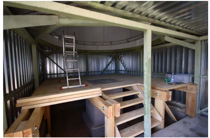
Abb.22: Der Zwischenboden ist nahezu fertig
