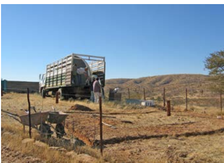
Abb. 8: Die Gräben für das Fundament sind bereits ausgehoben
