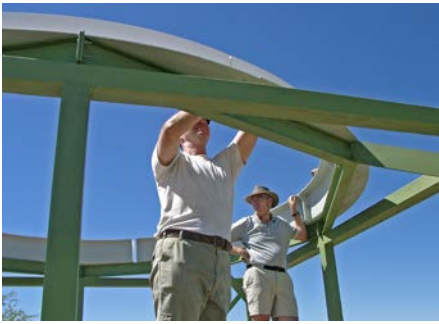
Abb.11: Der Stahlrahmen ist fertiggestellt und es kann mit der Montage der Kuppel begonnen werden
