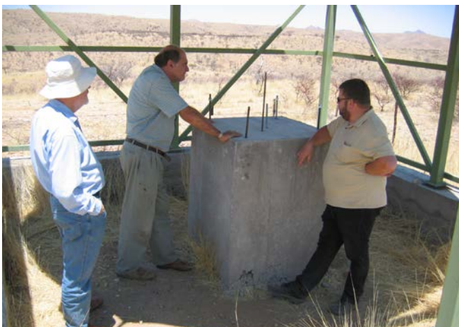
Abb.17: Die Anker für Erhöhung und seitliche Ansätze des Sockels sind angebracht
