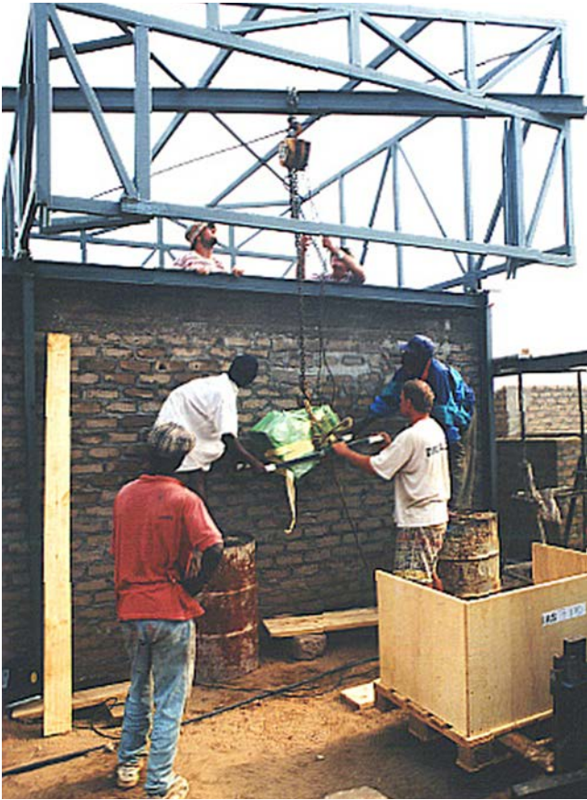
Viele Hände packen an: Die Liebscher-Montierung wird in das Sternwartengebäude gehievt
