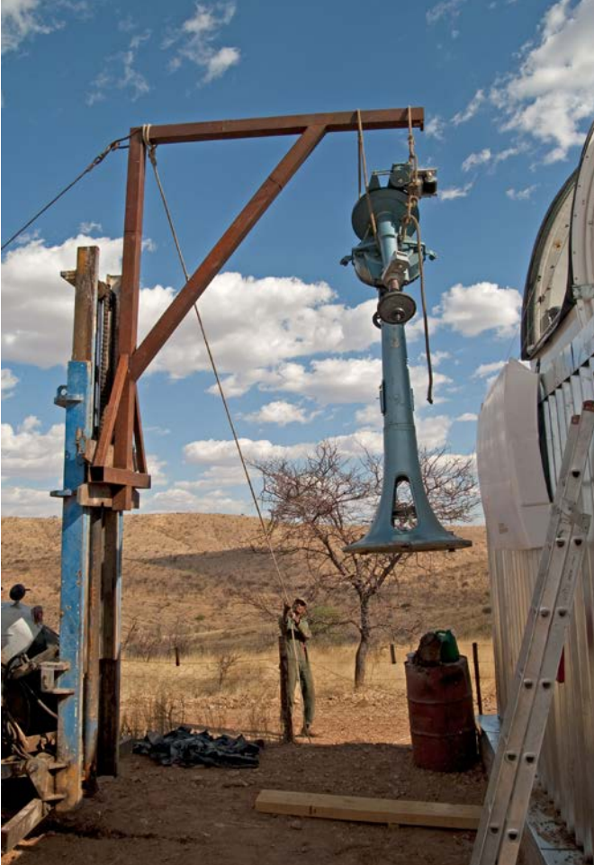
Abb.23: Das Einsetzen der Zeiss-Säule gestaltet sich fast ebenso kritisch wie das Aufsetzen der Kuppel
