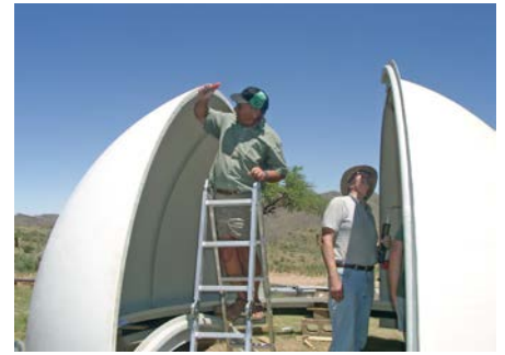
Abb.13: Sorgfältiger Zusammenbau und Abdichtung mit Akryl
