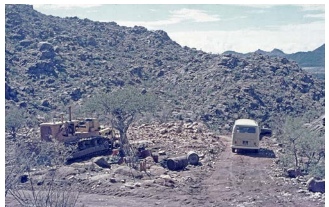
Abb. 4: Beginn der Arbeiten an der Pad
