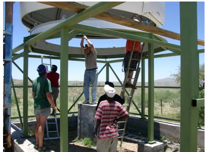
Abb.15: Vorsichtig wird die Kuppel mit dem Flaschenzug herabgelassen
