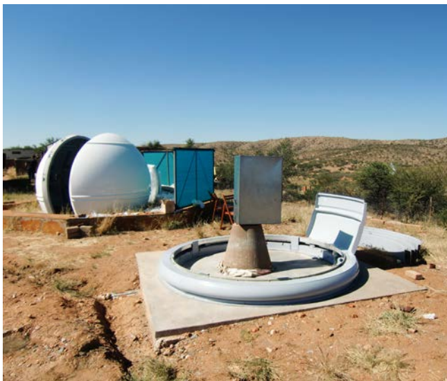
Abb. 1: Die Kuppelteile stehen bereit zum Aufbau
