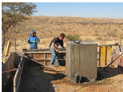
Abb. 9: Betonarbeiten für den Sockel
