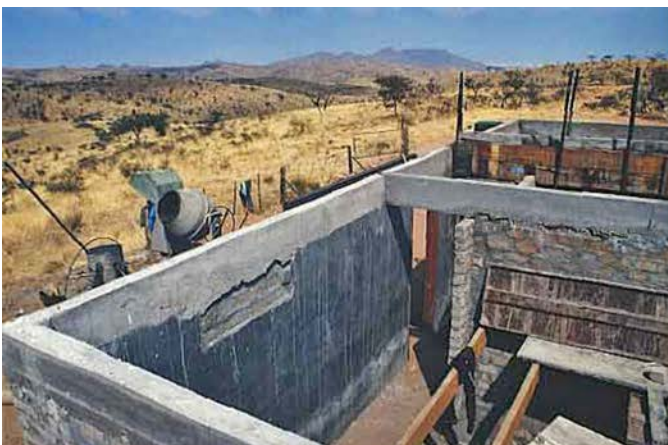
Der alle Mauern umschließende Ringanker ist beinahe fertig gestellt. Im Hintergrund sind der Gamsberg (links) und die Hakosberge (rechts) zu sehen
