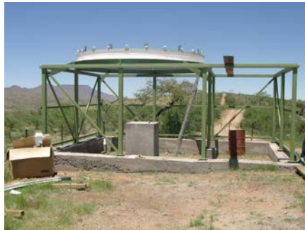
Abb.12: Der Laufring der Kuppel ist bereits aufgesetzt
