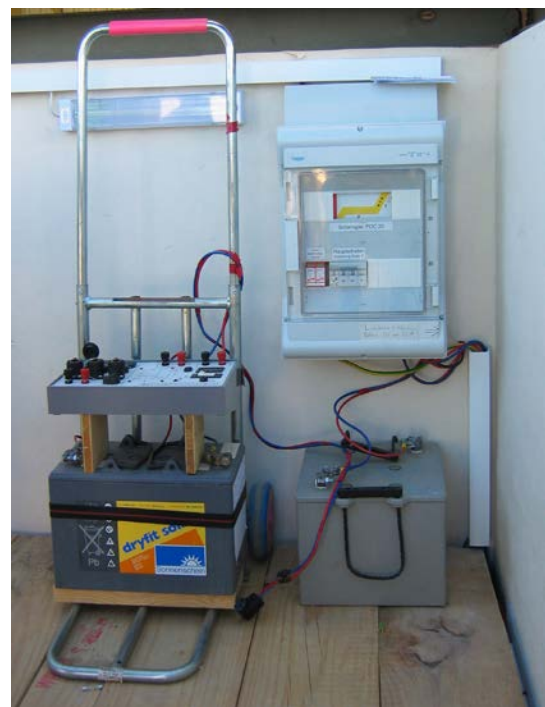
Abb. 5: Typische Einzelstation (Westraum Hauptgebäude)
