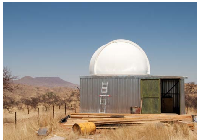
Abb.20: Das Kuppelgebäude ist bereit zum Innenausbau
