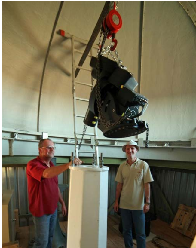
Abb.27: Montage von Säule und Montierung mit Leiter-Flaschenzug
