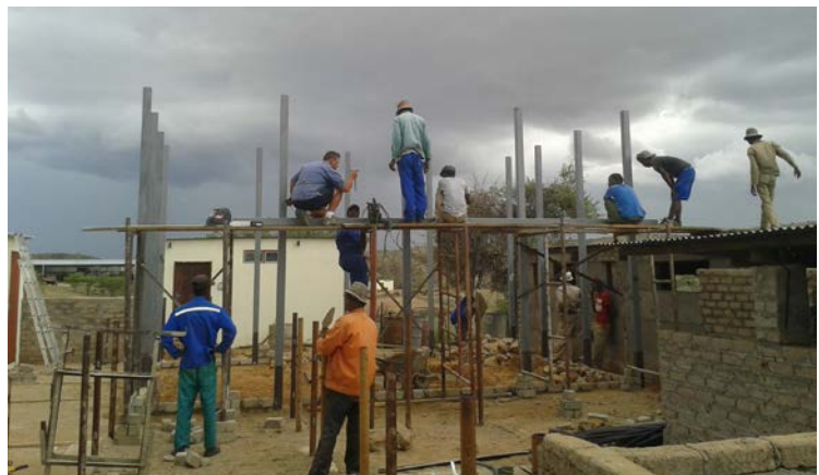
Beginn der Bauarbeiten auf Hakos. Das Sternwartengebäude wurde in Stahlrahmenbauweise ausgeführt
