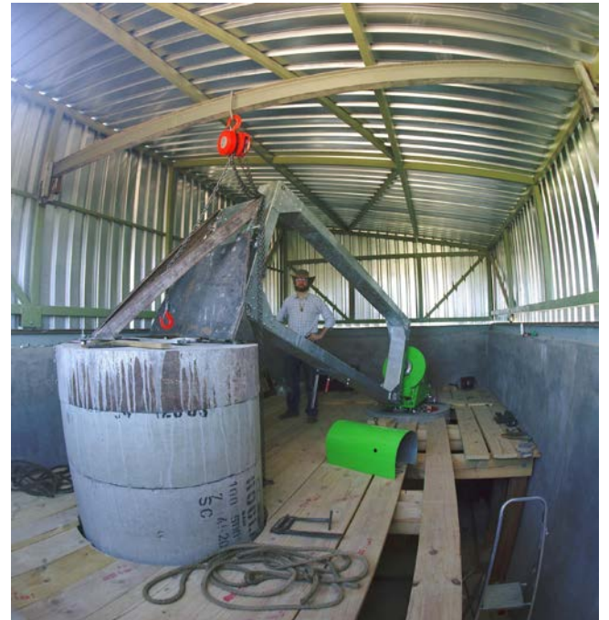
Abb. 10: Südsäule und Rahmen
