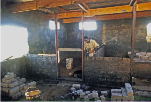
Die Wände der Innenräume werden gemauert. Der Sockel für die Säule der Liebscher-Montierung ist rechts zu sehen
