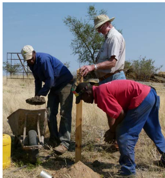
Abb. 7: Die Holzpfosten mit den aufgeschraubten Planetenmodellen werden einbetoniert
