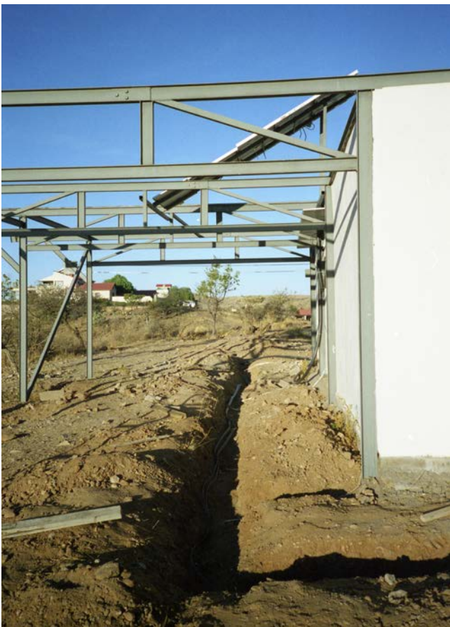
Abb. 1: Verlegung des Ringerders mit Anschluss an den Stahlrahmen des Gebäudes
