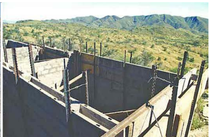
Der alle Mauern umschließende Ringanker ist beinahe fertig gestellt. Im Hintergrund sind der Gamsberg (links) und die Hakosberge (rechts) zu sehen
