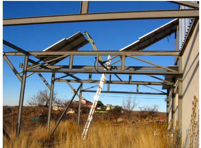
Abb. 2: Installierte Solarmodule am Hauptgebäude
