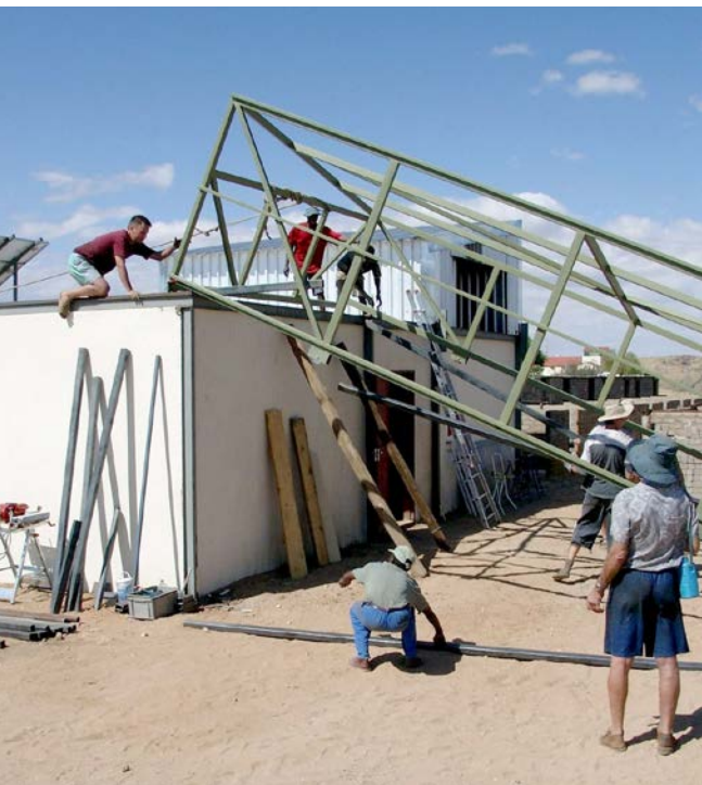
Abb. 6: Montage des Rolldachs
