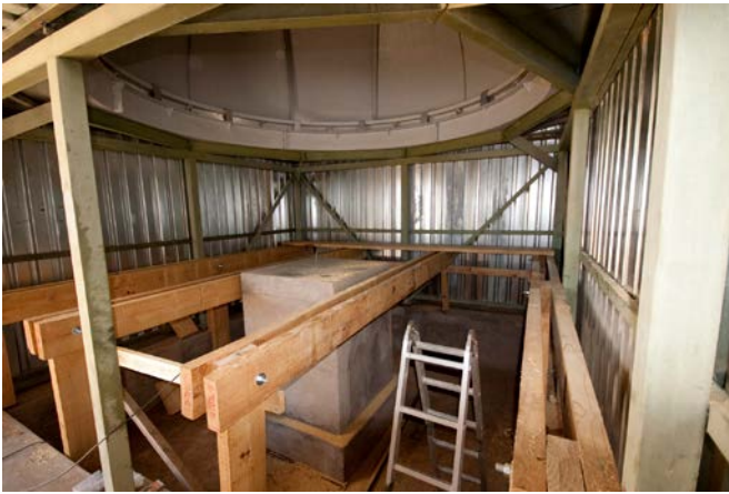
Abb.21: Die Tragkonstruktion des Holzbaus
