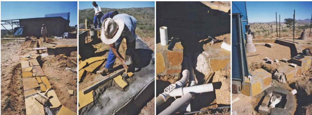
Arbeiten an Fundament und Kabelkanälen der ersten Außensäule
