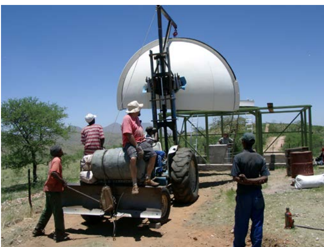
Abb.14: Alle verfügbaren Gegengewichte mussten zur Stabilisierung des umgebauten Traktors
